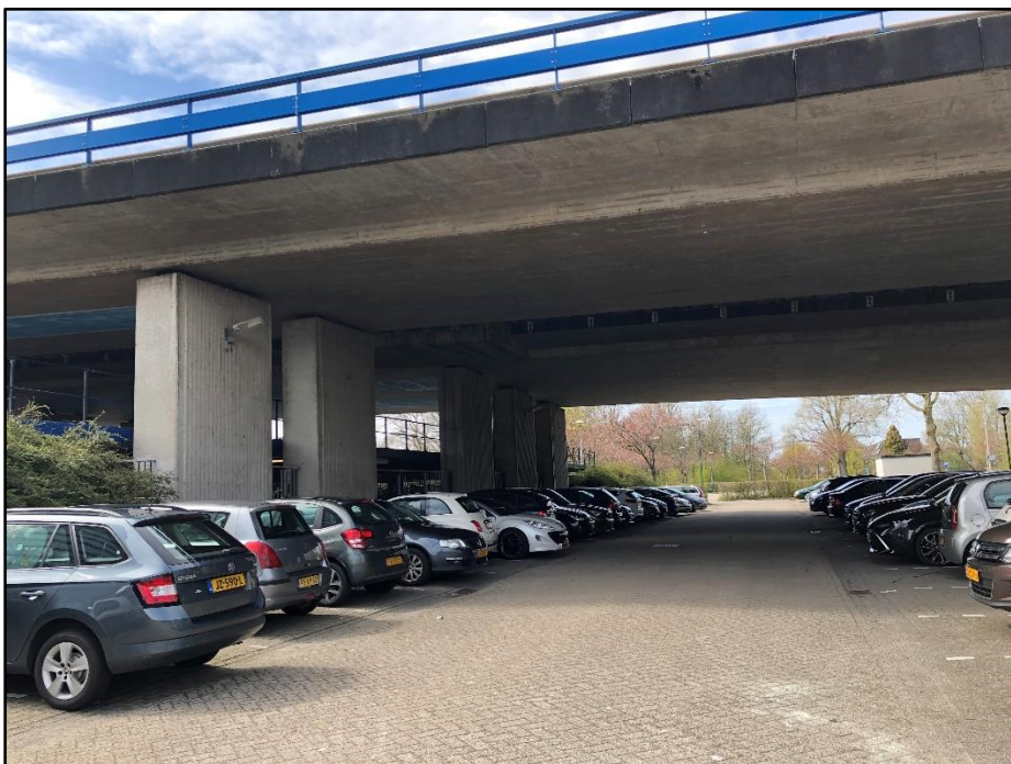
Figuur 5. Parkeerplaats, met daarboven het viaduct van de Afrikaweg. (Locatiebezoek Saricon, 8 april 2021)
