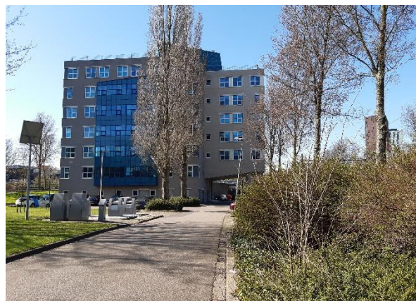
Zuidkant plangebied. Links het plangebied; rechts struiken en het spoor met bomenrij.
