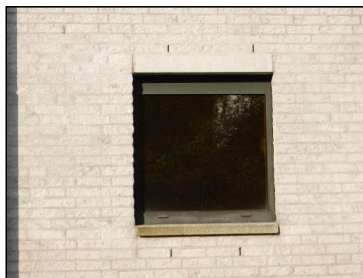
Afbeelding 4 & 5: Ruimte onder daklijst en open stootvoegen onder de dakrand en boven en onder de ramen.
