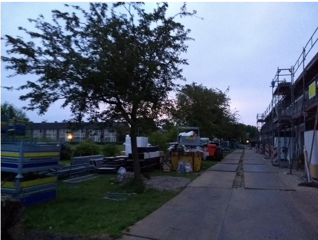
Bomen en struweel aan de westkant met potentie als broedplaats voor vogels. Let op de korte afstand tot renovatiewerkzaamheden.
