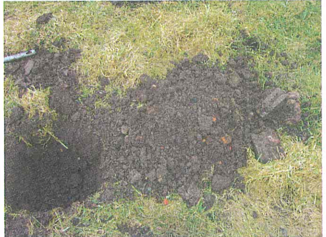
Fotonummer: 14 Omschrijving: Dempingsmateriaal sloot 30gz02020 (NO-zijde locatie)
