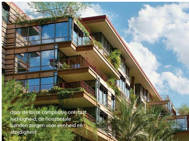
door de uitkragende horizontale vloerbanden ontstaan luchtigheid en alzijdigheid
