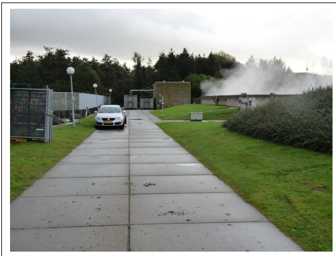
Foto 4. Aanzicht installatie afvalwaterzuivering
