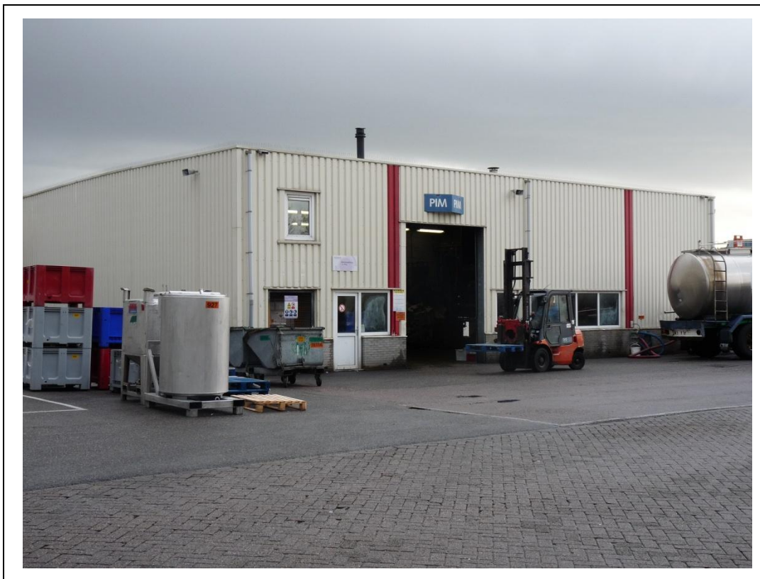
Foto 3. Te slopen PIM-gebouw
