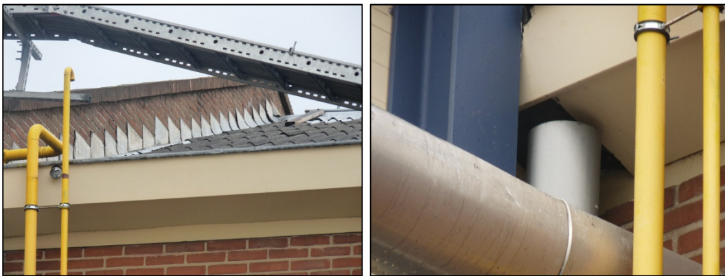
Figuur 12 en 13. Toegangsmogelijkheden voor vleermuizen magazijn.
