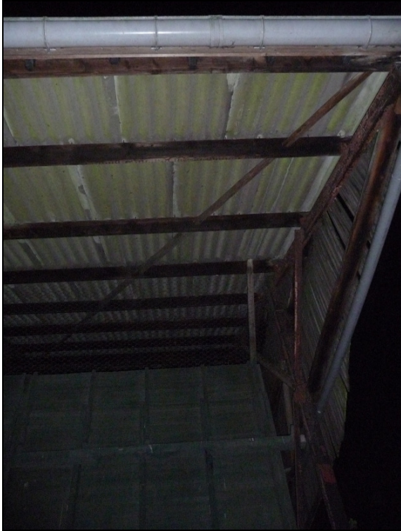
Figuur 2. Golfplaten dakconstructie schuur van waaronder tweemaal een uitvliegende Laatvlieger is opgemerkt. De precieze uitvliegplaats is vermoedelijk een kleine kier tussen een van de platen en/of een van de balken en bevindt zich ergens binnen het gefotografeerde gedeelte (N. de Zwarte).
