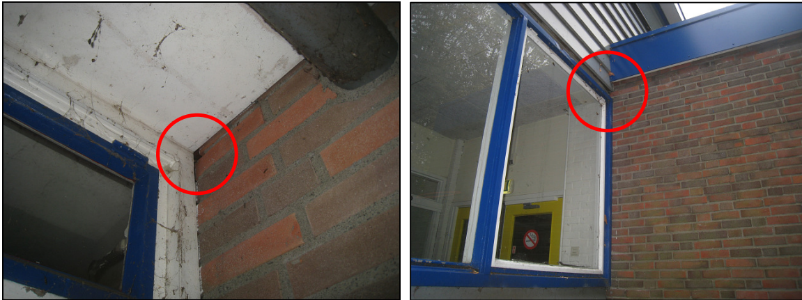
Figuur 1. Enkele aangetroffen openingen waardoor vogels en vleermuizen het gebouw binnen kunnen gaan.
