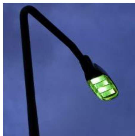
Figuur 6.4 Vleermuisvriendelijke verlichting. Geschikte verlichting vanwege zo kort mogelijke, of gebogen lantaarnpalen, lichtbeperkende armaturen zonder uitstraling naar boven toe en “zacht groen”.
