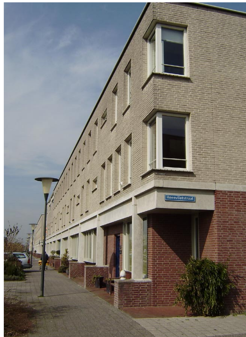
Foto boven: Bebouwing aan de Hagesteinstraat met duidelijke plint en diepe neggen.
