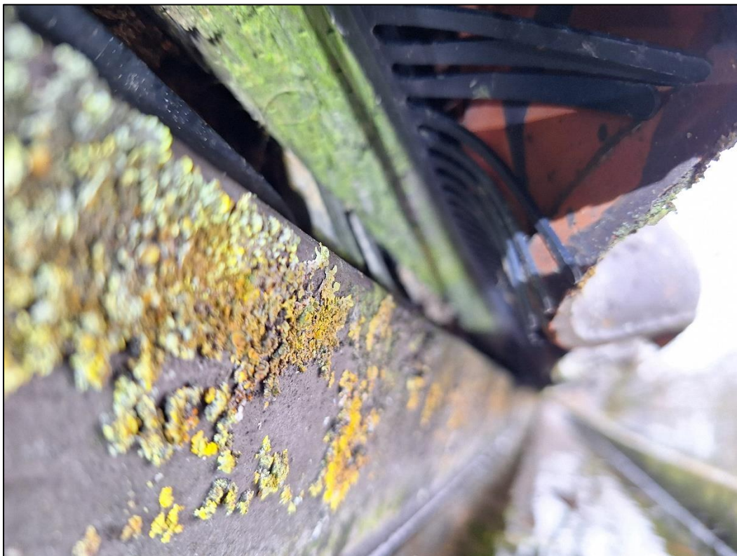
Figuur 2. Afscherming van dakpannen door vogelschroot.
