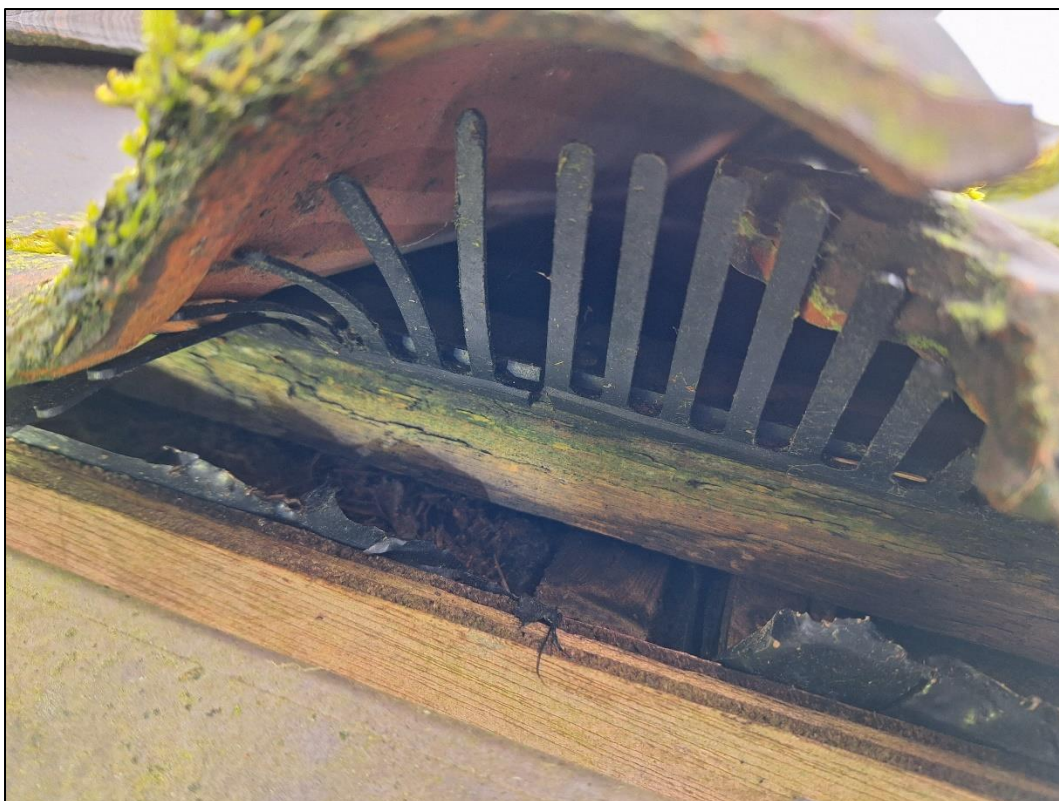
Figuur 3. Detailfoto van vogelschroot bij 1 van de pannen.
