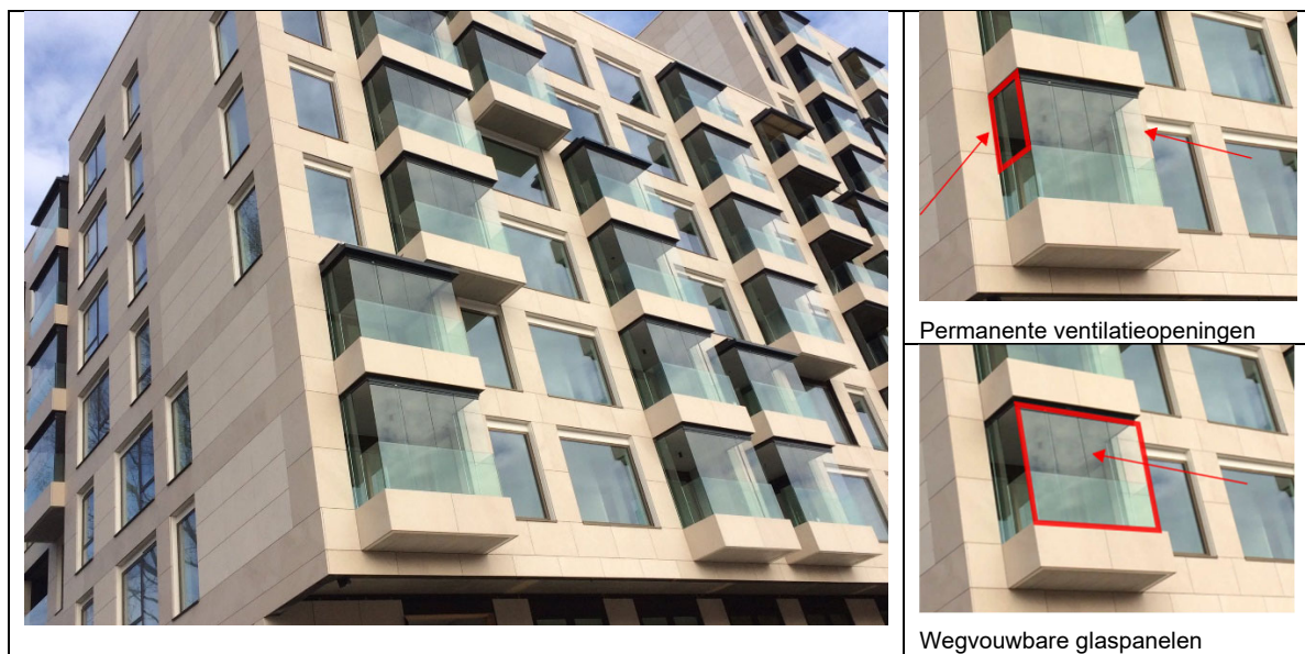
Figuur 6.1: Verglaasde balkons in project DeFred020 in Amsterdam
