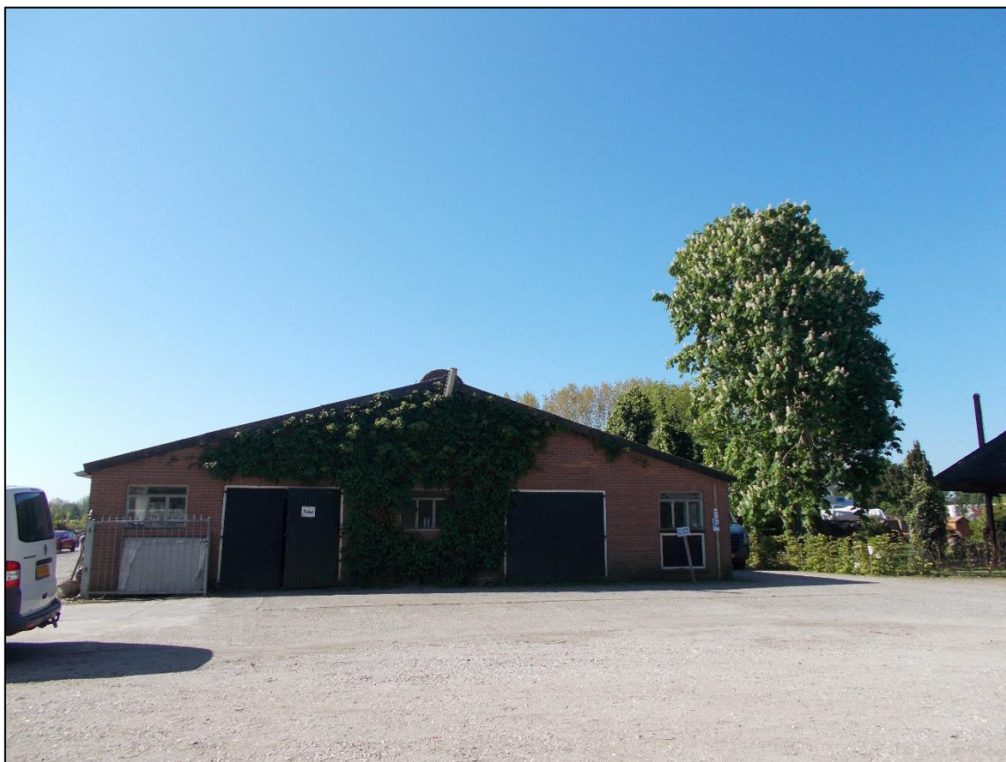
Figuur 3: Opslagschuur. Foto: NWC
