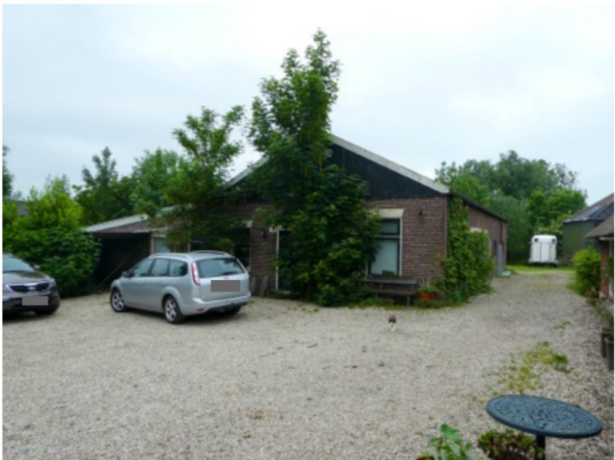
Te slopen Bijgebouw
