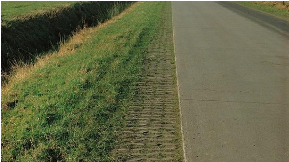
Voorbeeld verstevigde berm.
