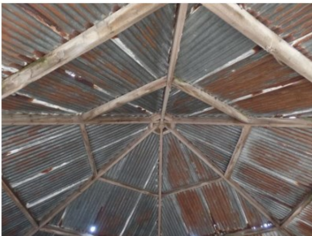
Figuur 9: Dak van de hooiberg
