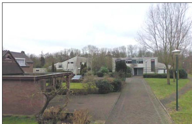
Direct aangrenzende woningen met lessenaarskap
