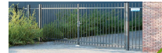
Draaiport, spijlen uitvoering. Geen hekwerk voor gevel
