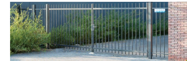
Draaiport, spijlen uitvoering. Geen hekwerk voor gevel
