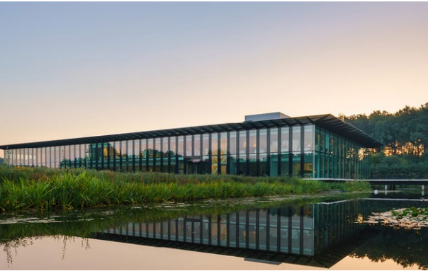
Heldere hoofdvorm, rechthoekige grondvorm, alzijdige oriëntatie.
