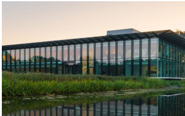
Verticale geleding dominant onder horizontale daklijst
