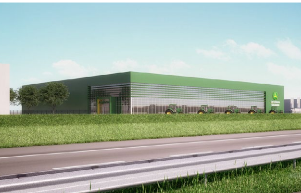
Alles in één volume en heldere hoofdvorm maar gevel is niet alzijdig: rondom gesloten volume heeft alleen aan snelwegzijde een (afwijkende) gevelopening.
