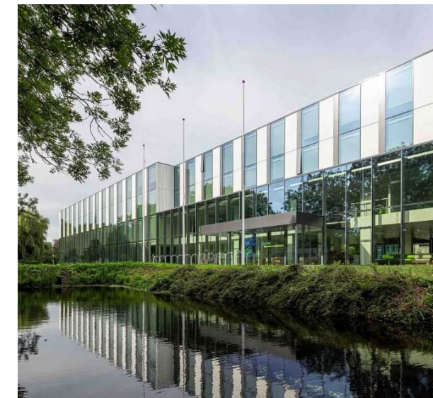
Figuur 36. Nieuwbouw Gemeentehuis Woerden
