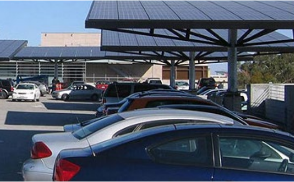
Parkeren op het dak gecombineerd met zonnepanelen
