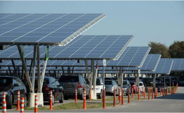
Parkeren op het dak gecombineerd met zonnepanelen
