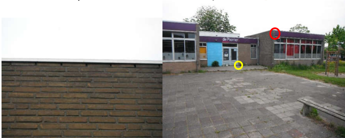
Figuur 3-1. Links een voorbeeld van open stootvoegen die door vleermuizen gebruikt kunnen worden om verblijfplaatsen in de spouwmuur te bereiken. Rechts een tijdens het eerste vleermuisonderzoek aangetroffen invliegopening (circa 10-15 invliegende vleermuizen, rood omlijnd) en de locatie waar rugstreeppad is waargenomen (geel omlijnd).
