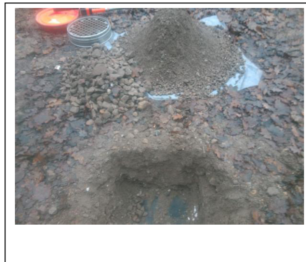
Foto 4. Asbestinspectiegat A04
