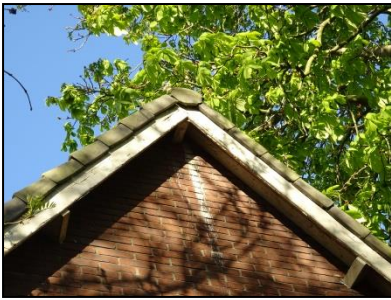
Figuur 9. Winterslaapplaats van boomkruipers onder afdak in de nok en ruimte onder de nokpan van de woning.
