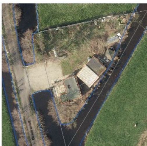
Afbeelding 1: luchtfoto 2014 huidige situatie
