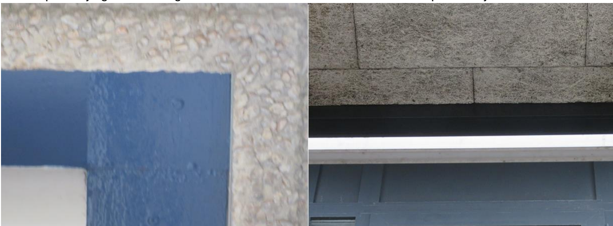
Fig. 5: naadloze aansluiting van beton op kozijnen.
