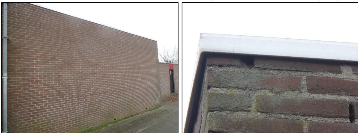
Figuur 3.5 Te slopen gebouw geschikt als verblijfplaats voor vleermuizen vanwege spouwmuur en open stootvoegen.
