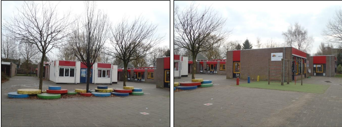
Figuur 3.2 De te slopen school heeft een plat dak zonder geschikte locaties voor gierzwaluw en huismus. De omliggende en groenblijvende beplanting is mogelijk wel geschikt.
