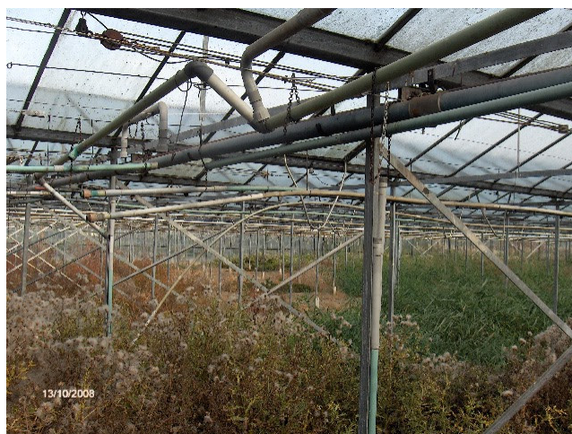
Interieur kas; geen asbest aangetroffen.
