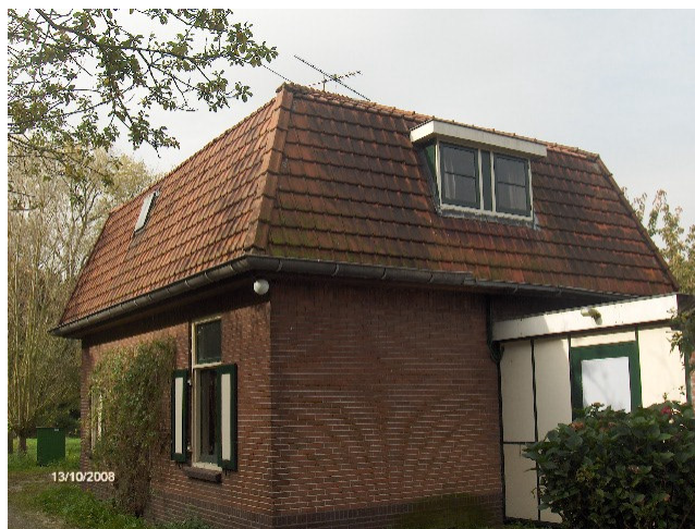
Achteraanzicht te slopen woning.
