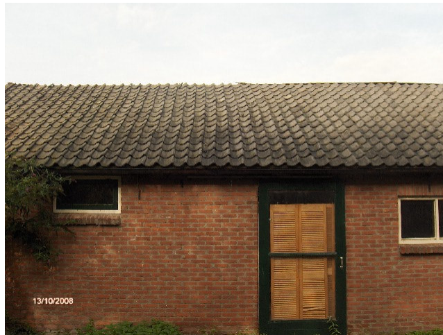
Schuur rechtsachter woning; geen asbest.
