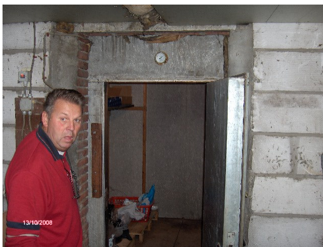
Koelcel in schuur van asbesthoudende plaat.
