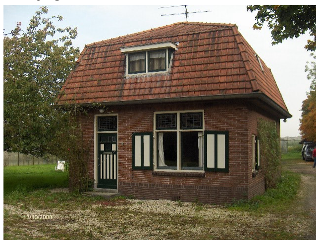
Te slopen woning (geen asbest aangetroffen).
