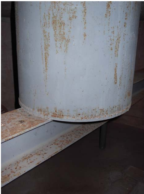
Stalen koker die rust op het in de buitengevels opgelegde HEA-profiel.
