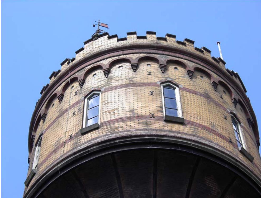
De 3 de geleding, hier bevond zich het reservoir. Bovenzijde van het metselwerk versierd met een rondboogfries en een borstwering met kantelen.
