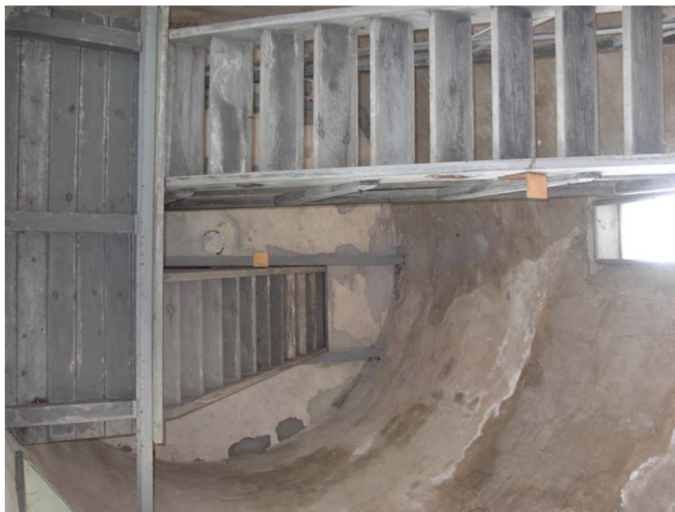
Onderzijde van de 3 de verdiepingsvloer. Duidelijk zichtbaar aan de onderzijde, de afgezaagde buis.
