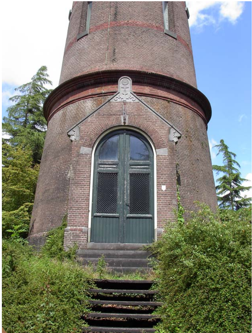
Entree en overgang van 1 ste en 2 de geleding van de watertoren te Woerden.
