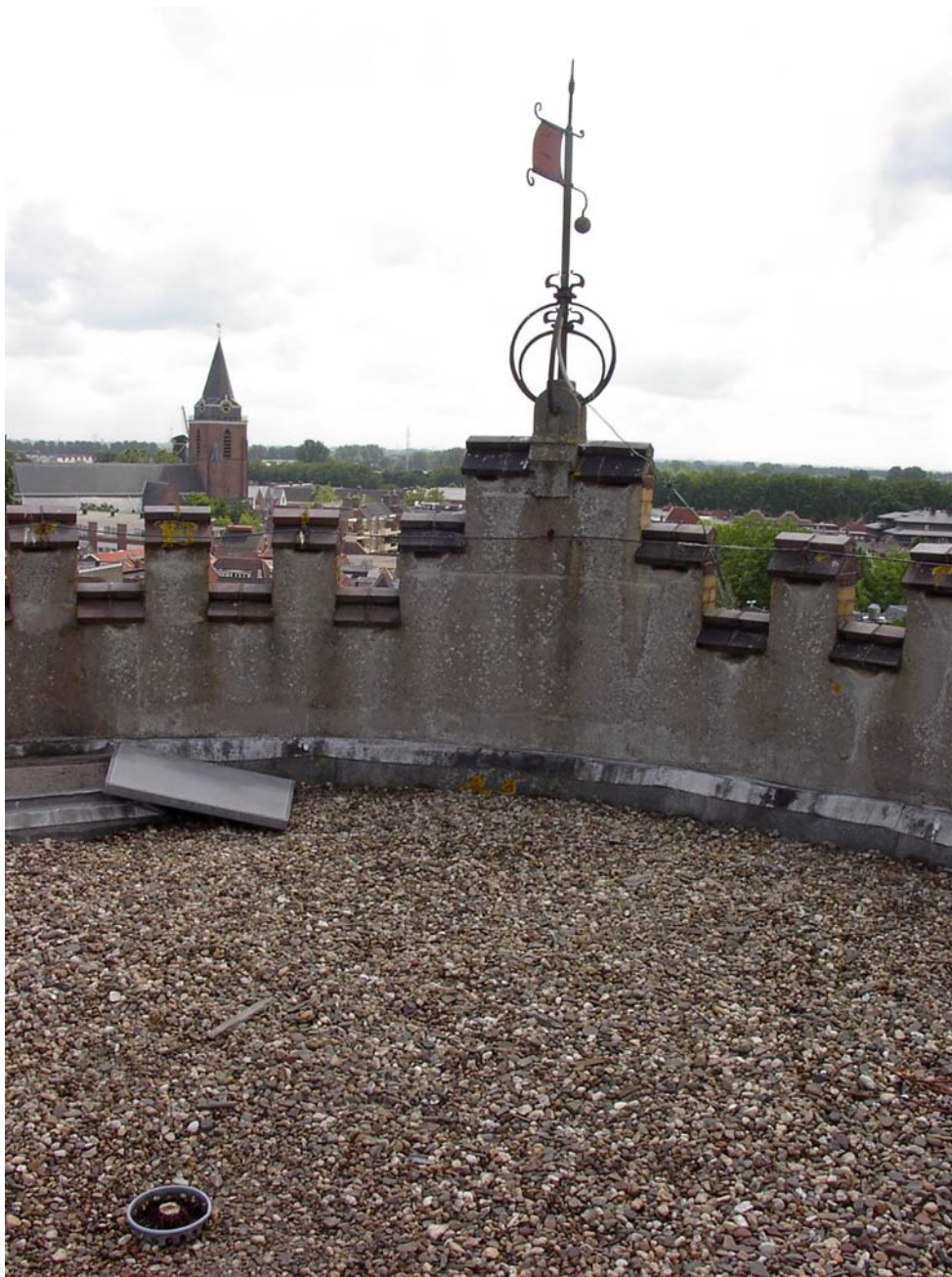
Borstwering met kantelen. De verhoging met het windvaantje. Links in het dakvlak het mangat en links onder de HWA.
