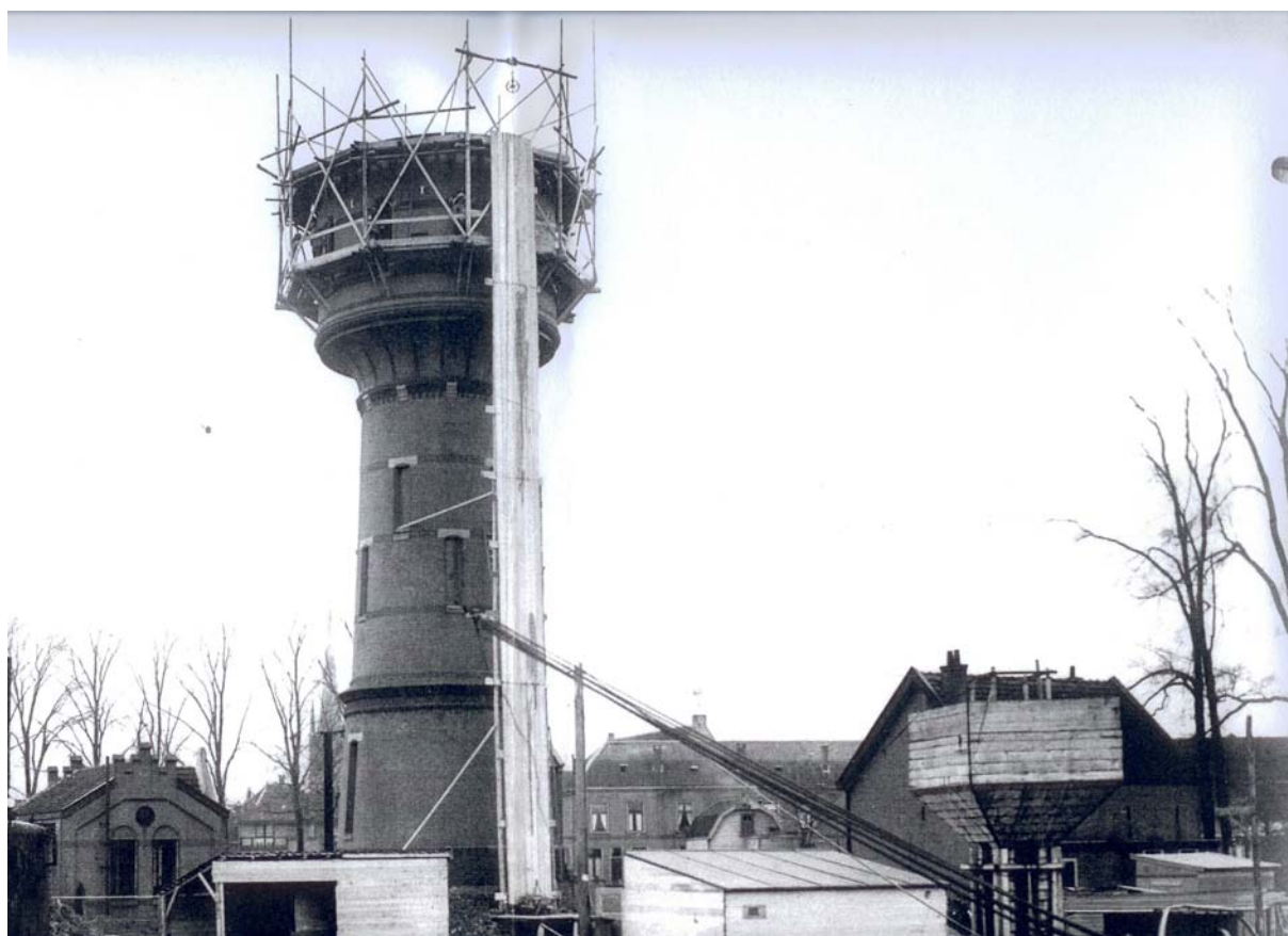
Bouw van de watertoren in Woerden 1906. Bouw van reservoir en dak (foto: 1906).
