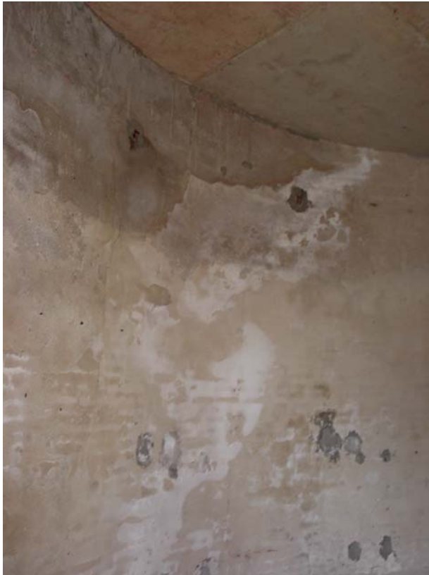
Afdrukken van de bekistingsplaat in de betonvloer van de 1 ste verdieping. Ook de afgezaagde ijzeren profielen in de wand van de begane grond.
