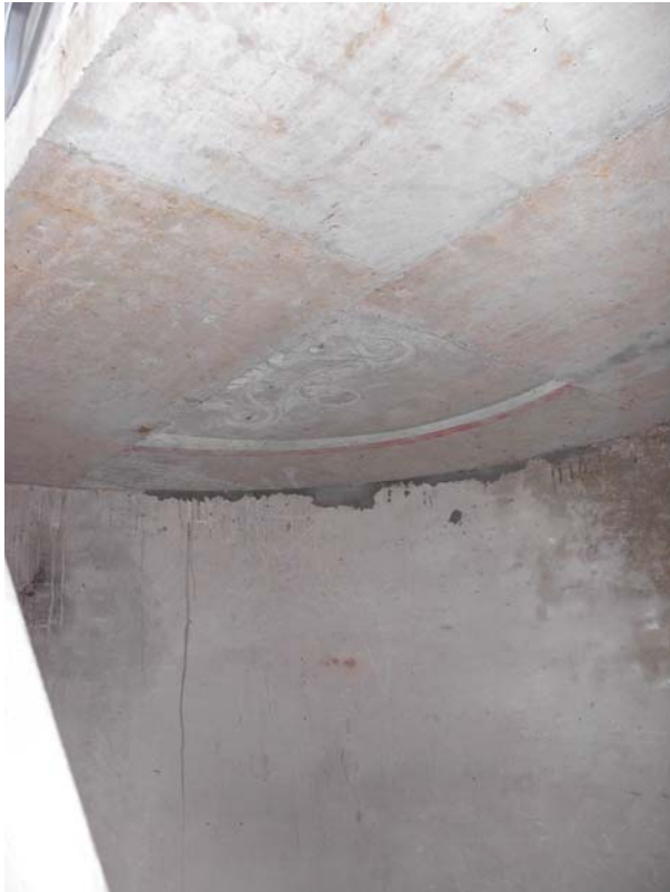
Afdrukken van de bekistingsplaat in de betonvloer incl. kleurenafdruk van de bekistingsplaat.
