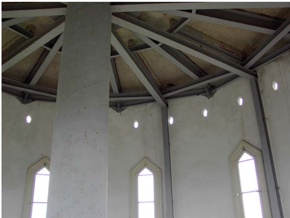
De ruitvormige gevelopeningen aan de bovenzijde en de staalconstructie van de dakvloer.
