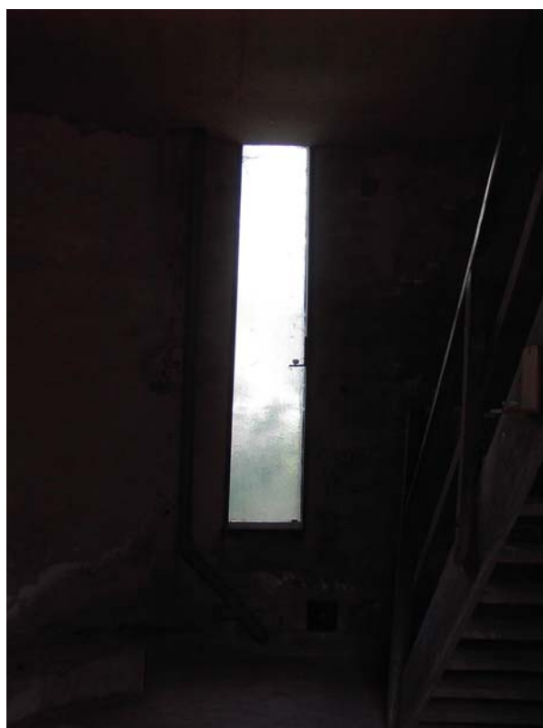
Gevelopening in de achtergevel (afgekapt door 1 ste verd.vloer). Links daarvan de HWA (PVC) en rechts van de gevelopening de sporen van de oude HWA.
