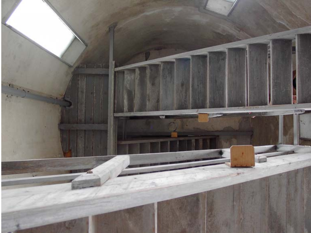
Interieur van de watertoren. Foto genomen vanaf de 2 de verdieping recht omhoog tegen de onderzijde van de 3 de verdieping.
