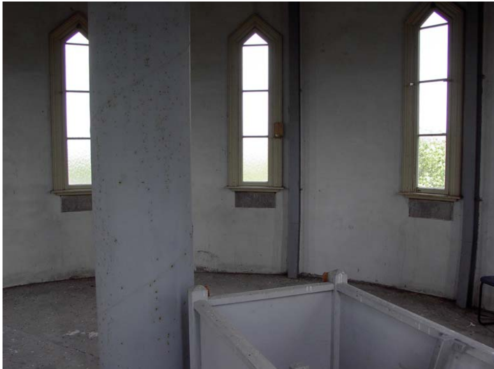
4 de Verdiepingsvloer met de smalle gevelopeningen en de stalenconstructie van de gevel.
