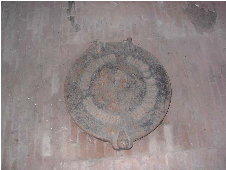
Het gietijzeren kelderluik in de begane grond vloer.
