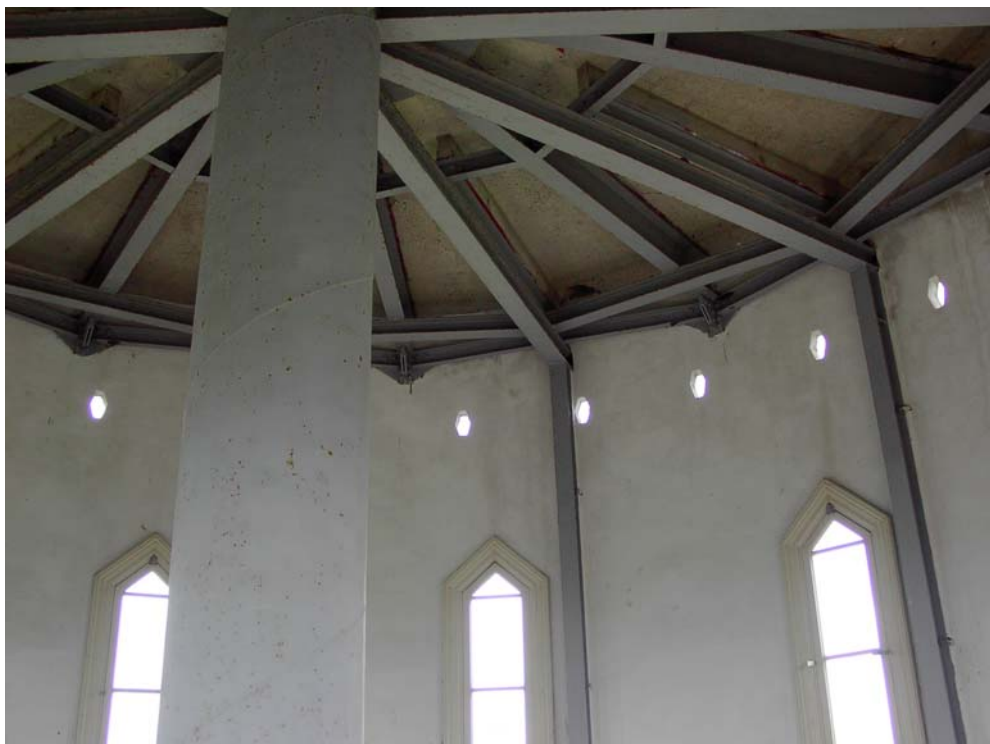
Stalen draagconstructie van de dakvloer.
