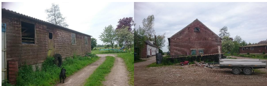
Overzicht van de onderzochte schuren binnen het plangebied aan de Van Teylingenweg 198 te Kamerik; te slopen houten schuur met asbestdak (links), op te knappen stenen schuur (rechts) (foto's Laneco).
