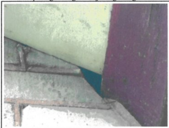
Foto 11: opening in de gevel bij een gording
