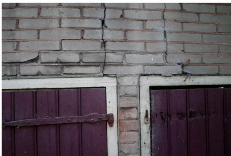
Afbeelding 15: nieuw metselwerk van kalkzandsteen boven de deurkozijnen, afwijkende steen en grijze voeg wijst op latere toevoeging.
