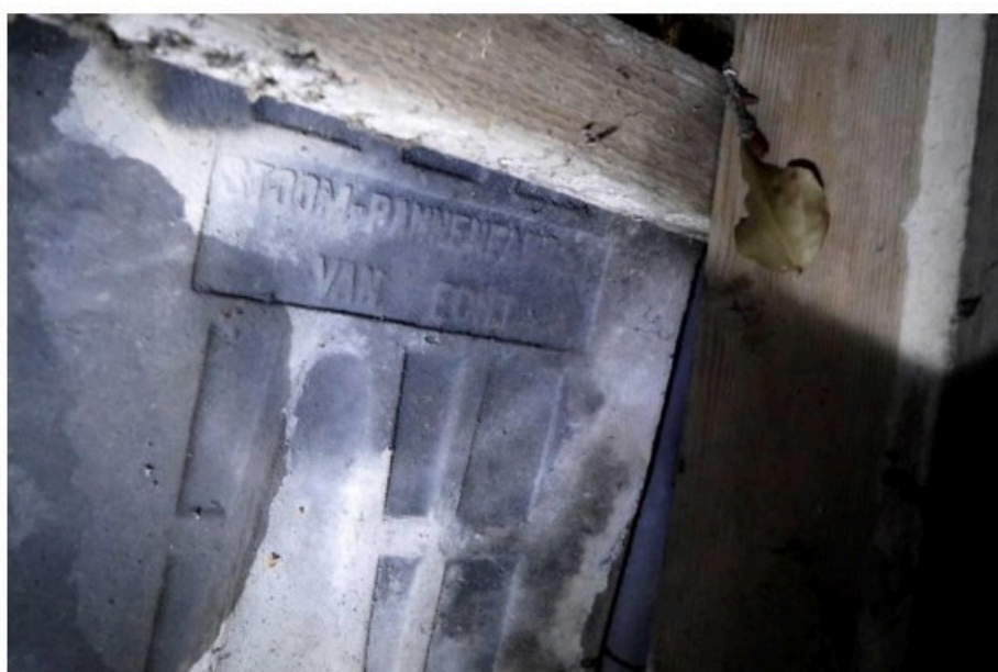
Afbeelding 30: Fabrieksstempel van de Stoompannenfabriek van Echt op de binnenzijde van een zwart gesmoorde kruispan op het westelijk dakvlak.
