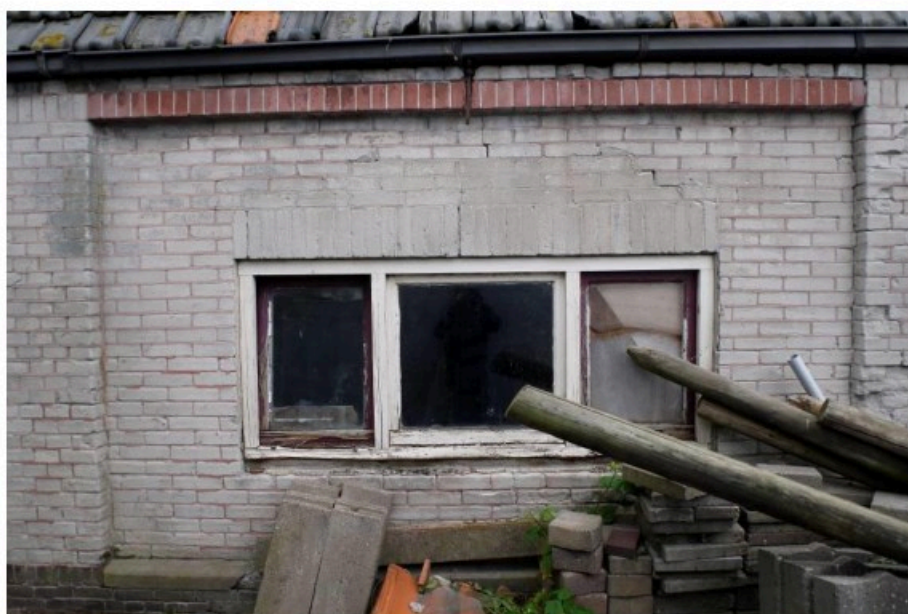
Afbeelding 24: Latere toevoeging in derde spaarveld, een drieruits venster. De herstellingen boven de rollaag geven de contouren aan van een gemetselde vensterboog.
