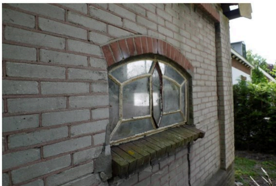
Afbeelding 9: gietijzeren stalraam onder gemetselde vensterboog, vensterdorpelstenen zijn geprofileerde verblendstenen.
