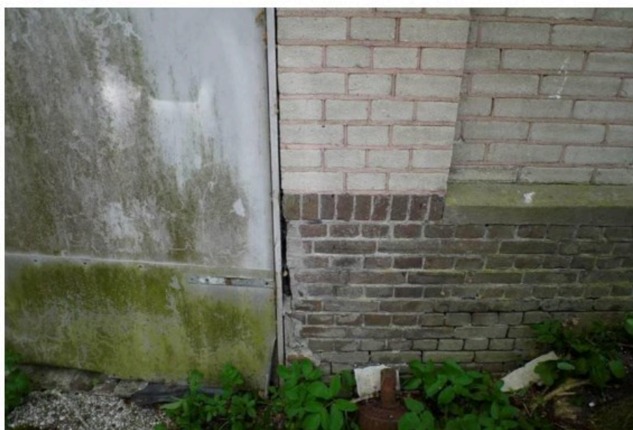
Afbeelding 8, detailopname moderne deuren, trasraam met kleinere stenen, afwaterende mortelafwerking en metselwerk van witte kalkzandstenen in waalformaat met gekleurde mortel.
