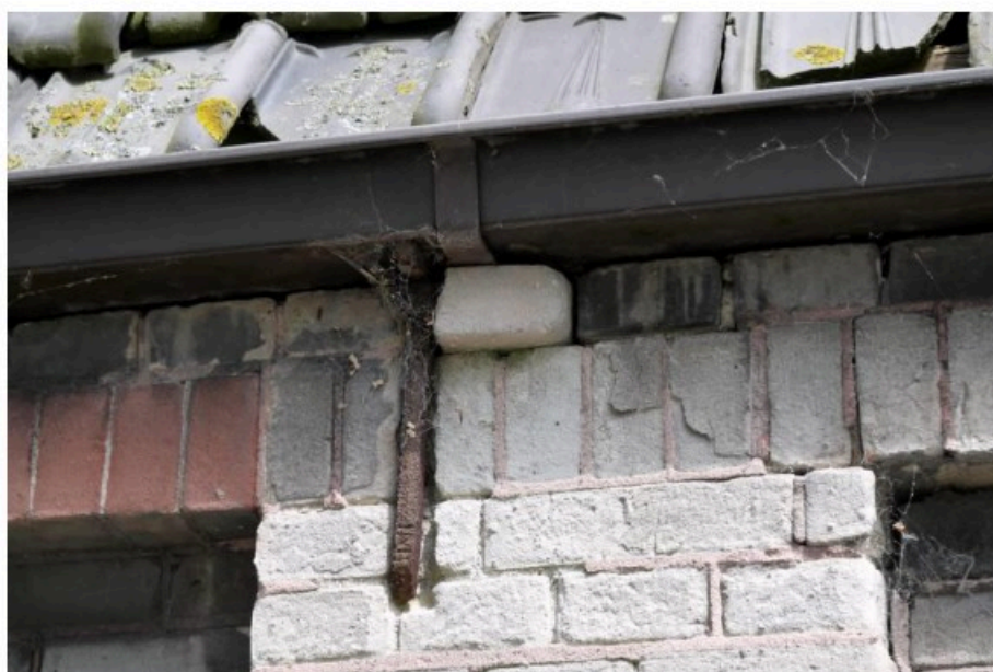
Afbeelding 33: Gootanker op penant westgevel.
