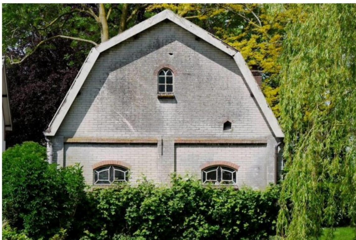
Afbeelding 17: zuidgevel gezien vanaf de overzijde van de Oude Rijn.
