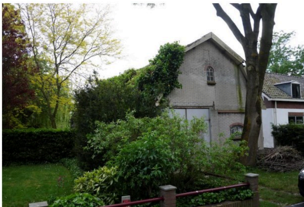
Afbeelding 1: Schuur gezien vanuit het noordoosten.
