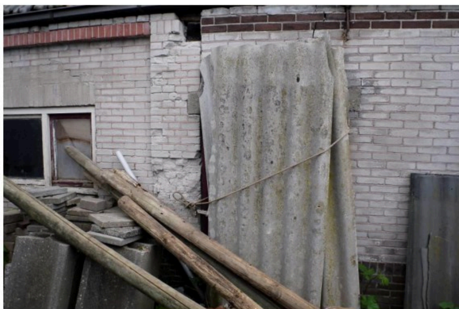
Afbeelding 25: Vierde spaarveld, geheel vernieuwd in kalkzandsteen. Achter de minerale platen is de gegoten betonlatei zichtbaar.
