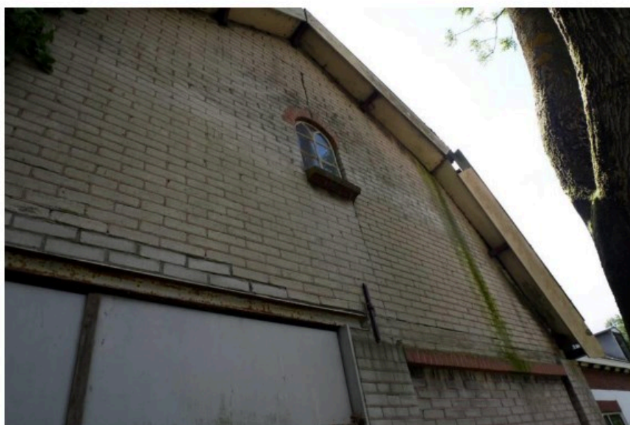
Afbeelding 10: Later aangebrachte stalen latei, hersteld metselwerk, muuranker en centraal geplaatst gietijzeren venster in de topgevel.
