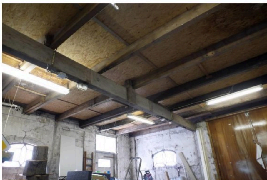
Afbeelding 35: Balklaag van de verdiepingsvloer, links de sporen van de verwijderde wand.
