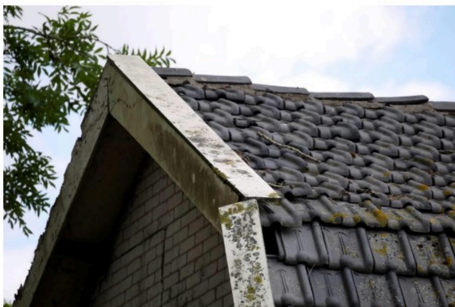
Afbeelding 31: Noordelijke topgevel met dek- en windveren, gesmoorde kruispannen en aangesmeerde holle vorsten van het westelijke dakvlak.
