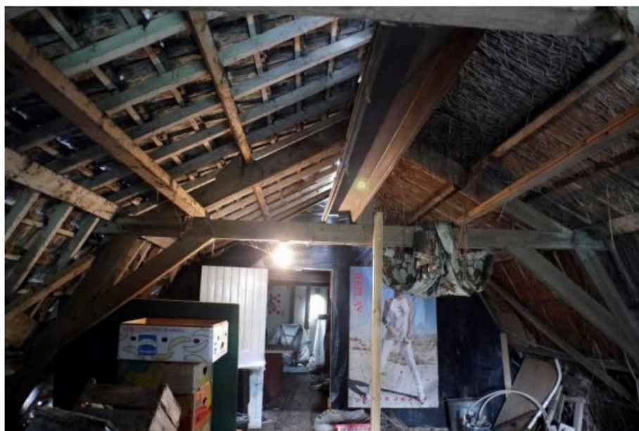
Afbeelding 29: Opname richting het noorden.
