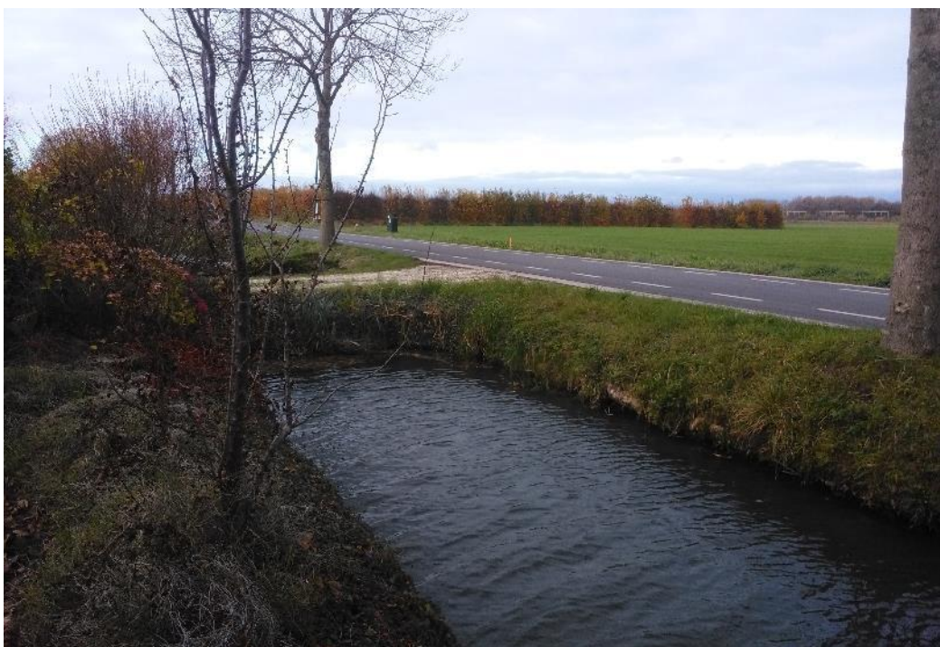
Figuur 4 De oprit naar de bedrijfswoning betreft een toegangsbrug over de sloot die het perceel begrenst. Onder de oprit is een duiker gelegen die de wateren aan beide kanten verbindt. De toegangsbrug wordt in de beoogde ontwikkelingen een stuk naar het oosten verplaatst.
