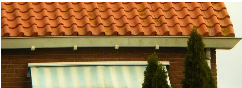
Figuur 4 De woning is voorzien van een onderste rij dakpannen die aan de voorzijde dicht zijn, waardoor soorten als huismus er niet onder kunnen nestelen.
