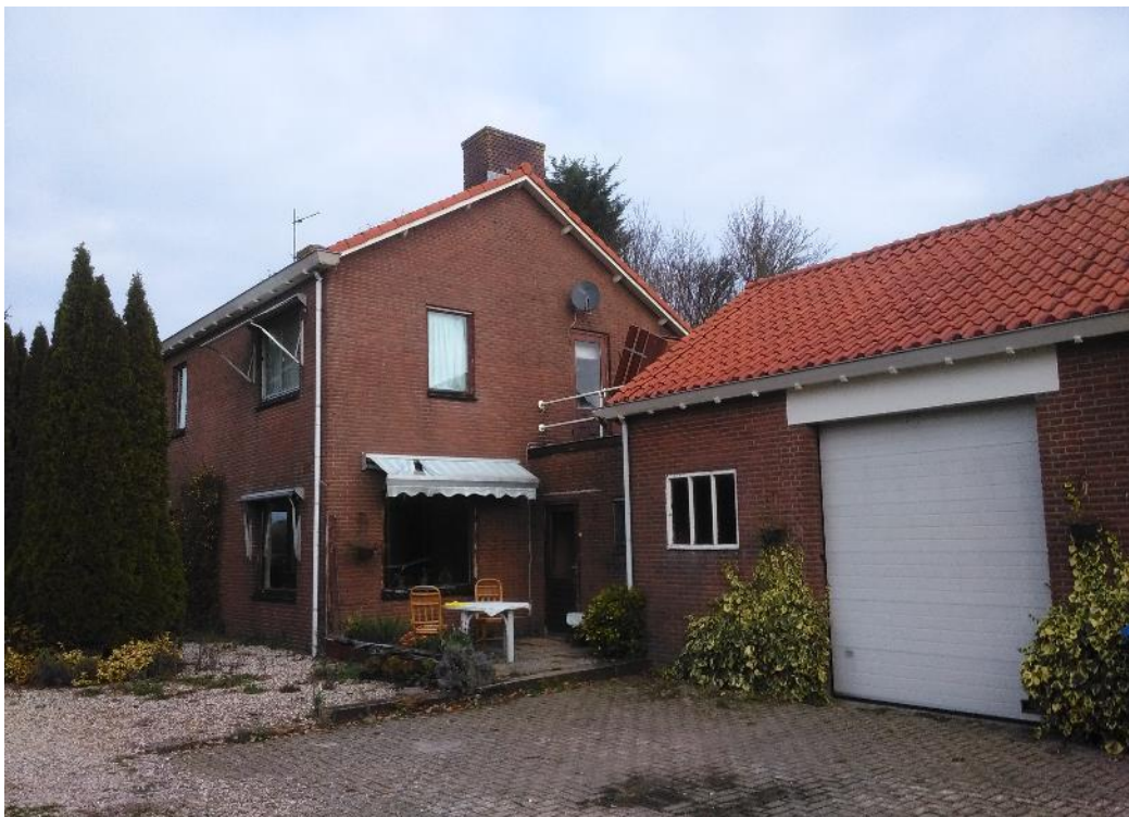
Figuur 2 De bedrijfswoning en het bedrijfspand zijn opgetrokken uit bakstenen muren en een zadeldak met dakpannen. Het erf rondom de gebouwen is grotendeels verhard met klinkers of kiezels. Rondom de gebouwen is groen aanwezig in de vorm van struiken, bomen en hagen.
