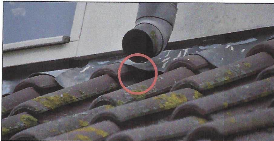
Figuur: op verscheidene plaatsen op het dak zijn openingen onder het lood of ruimtes onder losse dakpannen aanwezig. Hier kan huismus nestelen en vleermuizen kunnen hier verblijfplaatsen hebben.
