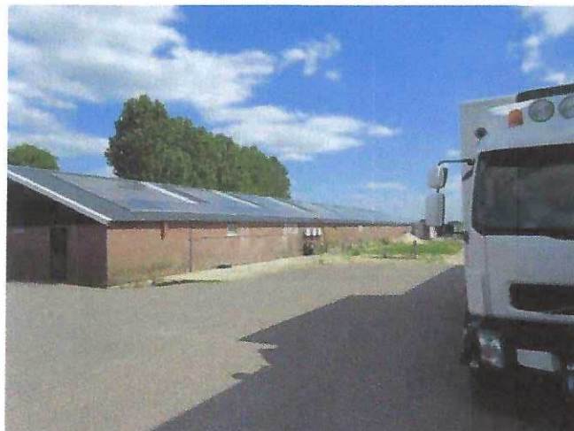
De stallen, met daken vol zonnepanelen.
