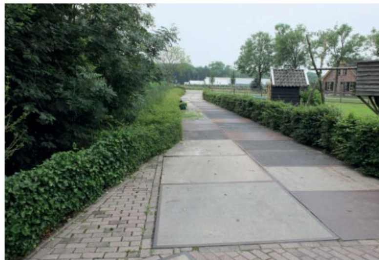
Inrit ten behoeve van de achterliggende schuren
