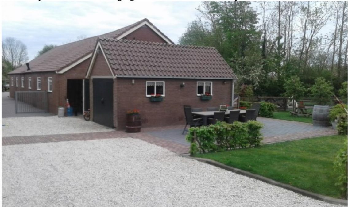
Foto 3: Zijaanzicht stenen berging met daarachter de zuidelijke schuur
