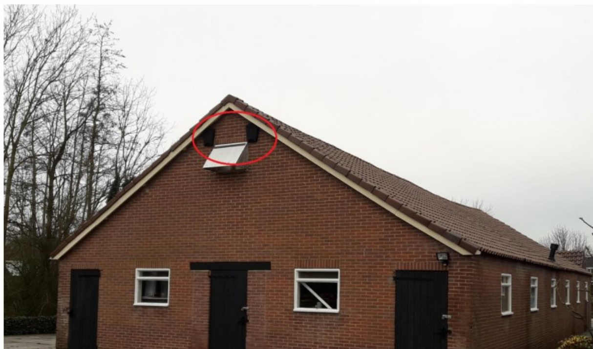
Afbeelding 6.2 Vleermuiskasten achterzijde loods (zuid /zuid west)
