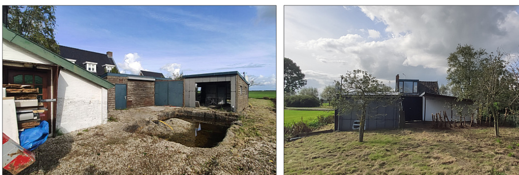
Figuur 12. Overzicht gebouw met opstallen vanaf de weg gezien links en vanaf de achterkant gezien rechts.
