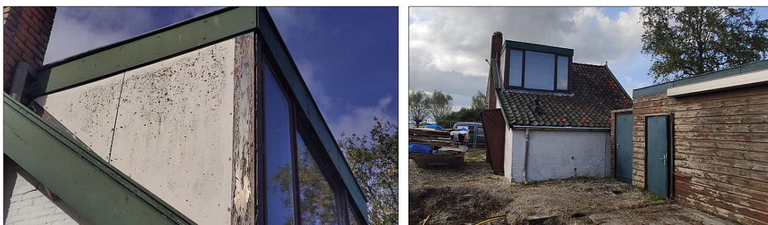
Figuur 14. Dakkapel goed inspecteerbaar en rechts te zien hoe laag het dak doorloopt aan de achterkant.
