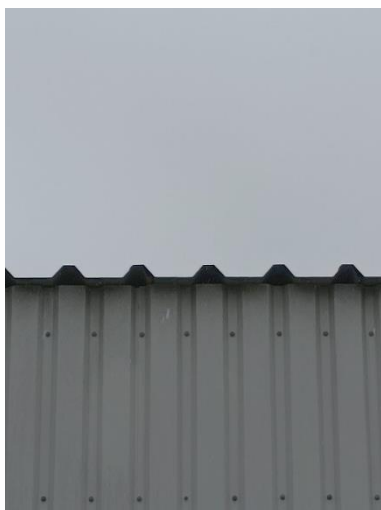
Figuur 4.4.4. Het golfstalen dak van de wasstraat.
