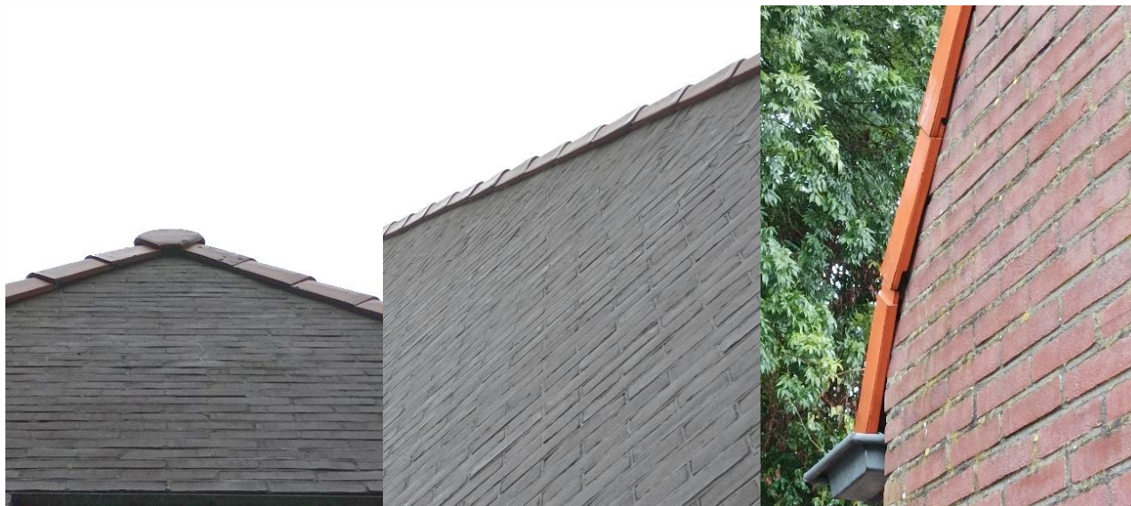
Figuur 4.4.1. Een beeld van de gevels en de overstekende gevelpannen bij de woning (links en midden) en het bijgebouw (rechts).
