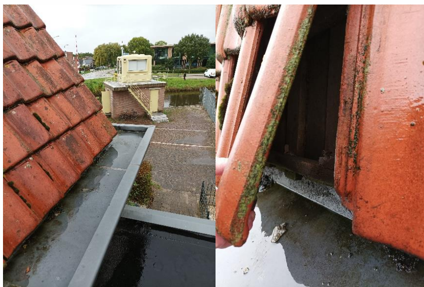
Figuur 4.4.2. De ruimte tussen de dakgoot en de onderste rij pannen.
