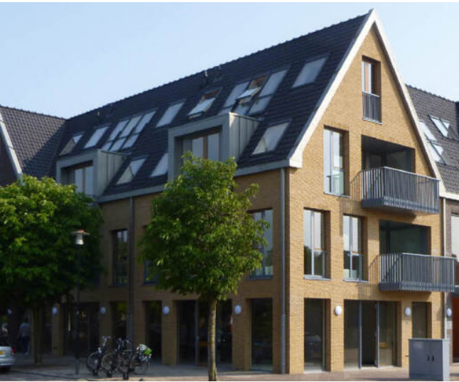
Het volume is eenduidig met karakteristieke kap
