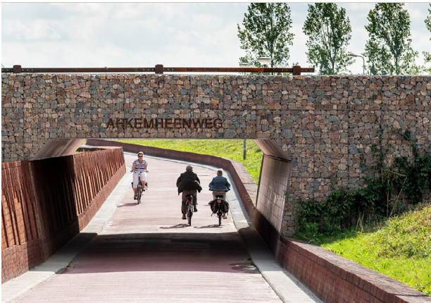
Fietstunnel met keerwanden rood-bruine (bak)steen
