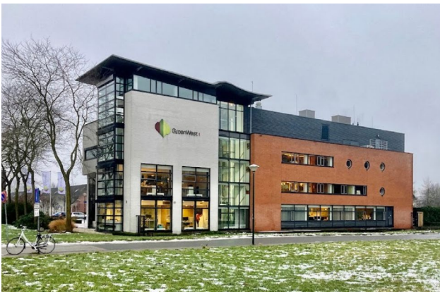
GroenWest gebouw (Zuid)
