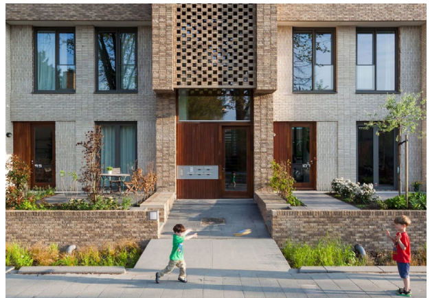
Plint zichtbaar over 2 lagen
