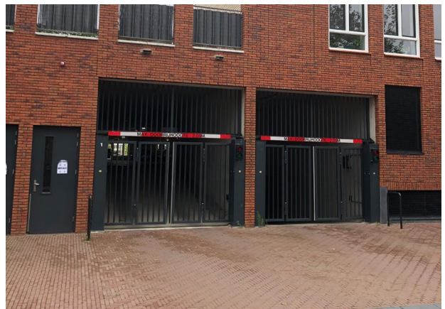
Entree parkeergarage als onderdeel van de plint
