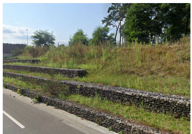
Schanskorf met puin als talud
