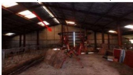
Foto 34 | Foto voor bron Cementplaat
