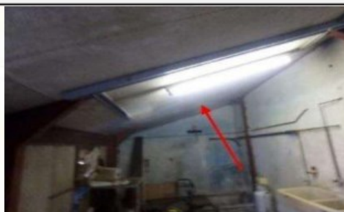
Foto 31 | Foto voor bron Cementplaat
