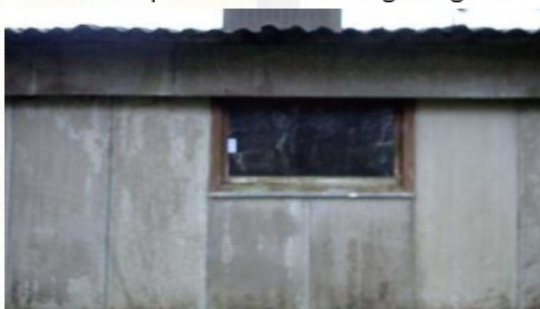
Foto 39 | Foto voor bron Beglazingskit
