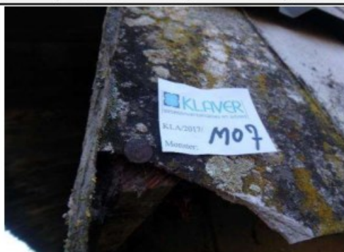
Foto 26 | Foto voor bron Cementplaat
