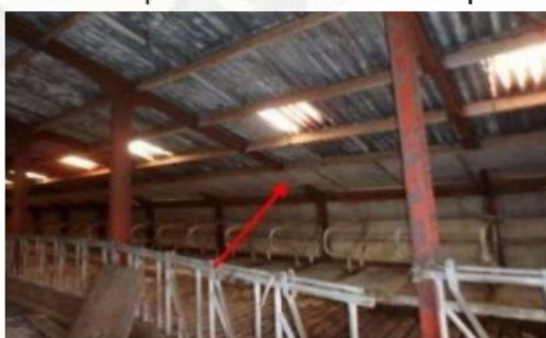
Foto 33 | Foto voor bron Cementplaat
