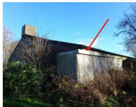
Foto 29 | Foto voor bron Cementplaat
