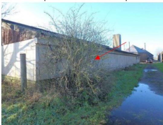
Foto 25 | Foto voor bron Gevelpanelen
