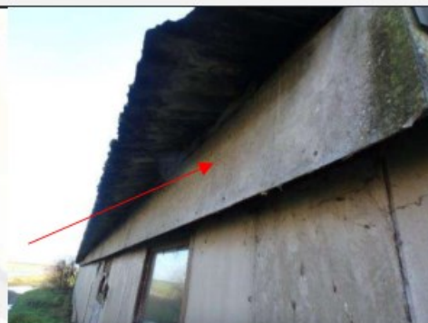
Foto 27 | Foto voor bron Cementplaat
