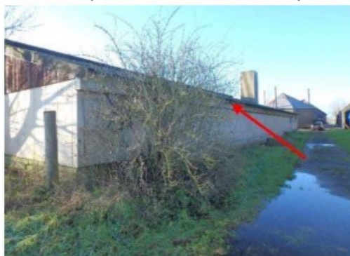
Foto 28 | Foto voor bron Cementplaat
