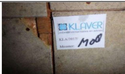
Foto 30 | Foto voor bron Cementplaat
