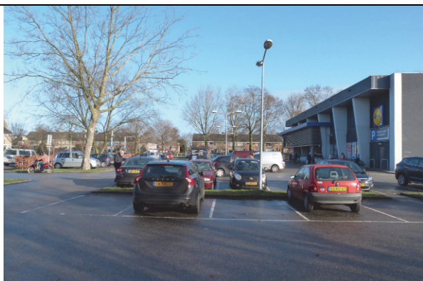
Figuur 3: Voorzijde supermarkt, gezien vanaf de noordwesthoek van het terrein
