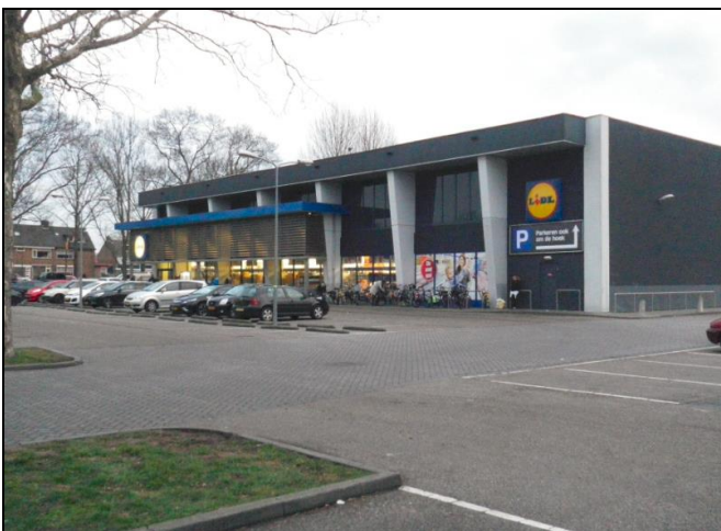
Figuur 6: De Lidl-supermarkt in de voormalige sporthal, gezien vanuit de noordoosthoek van het plangebied, kijkende in (zuid)oostelijke richting (februari 2017).
