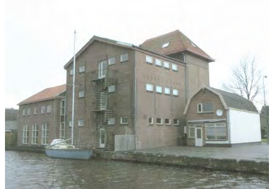
Achterzijde pand met naastgelegen woning.
