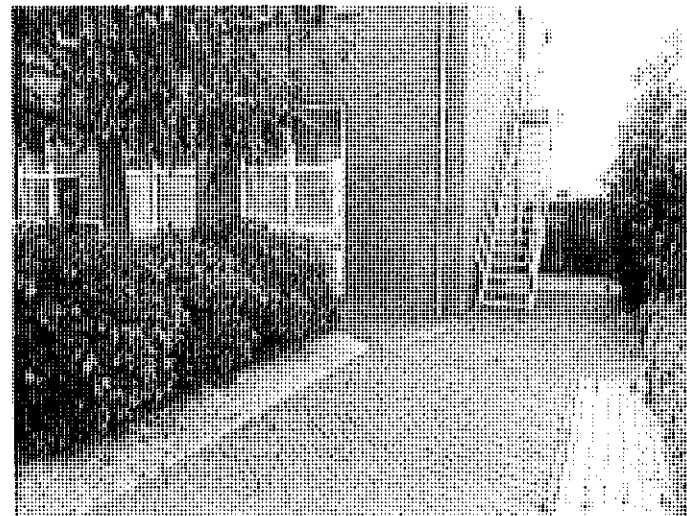
foto 6: Westzijde van de onderzoekslocatie
