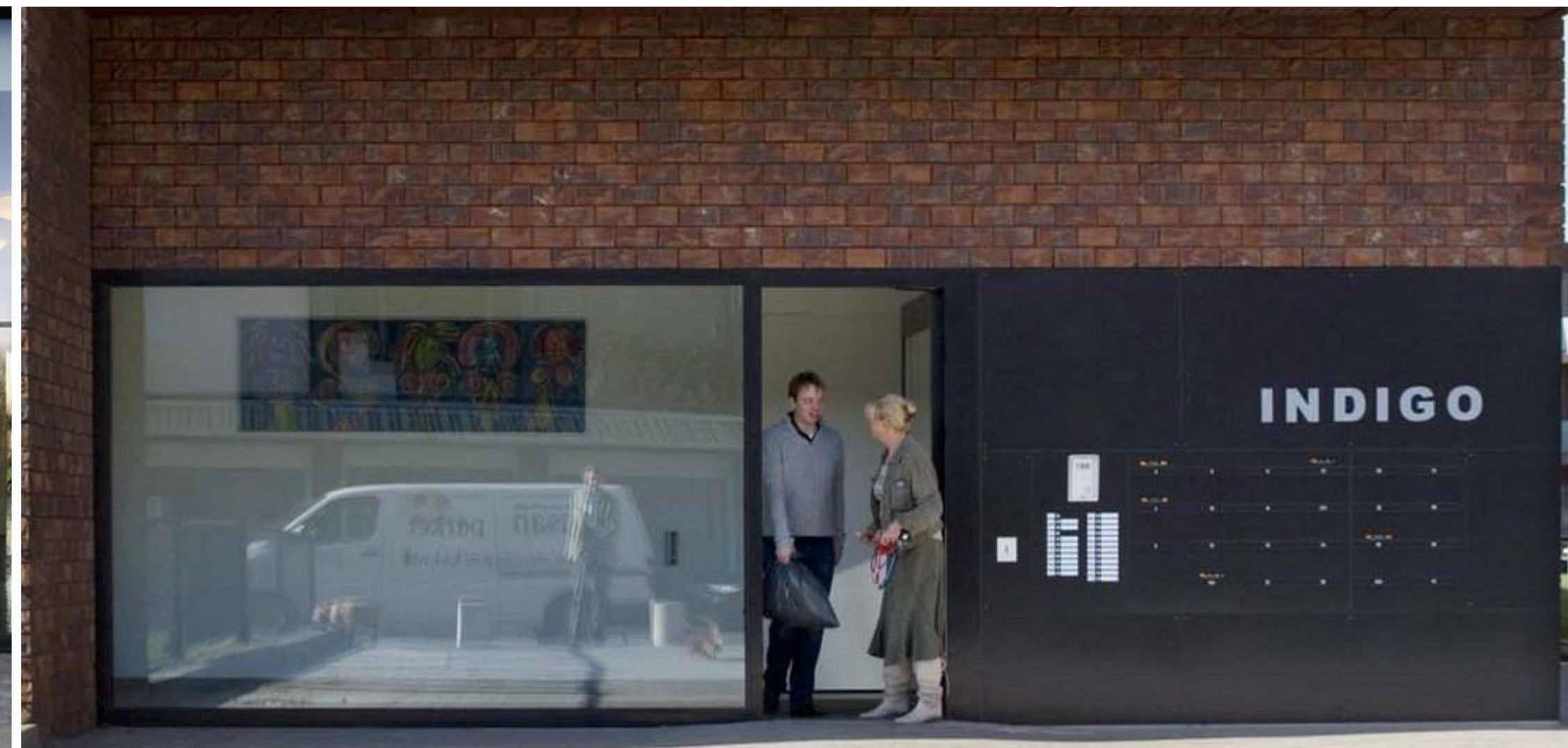
Postkasten in het gevelvlak
