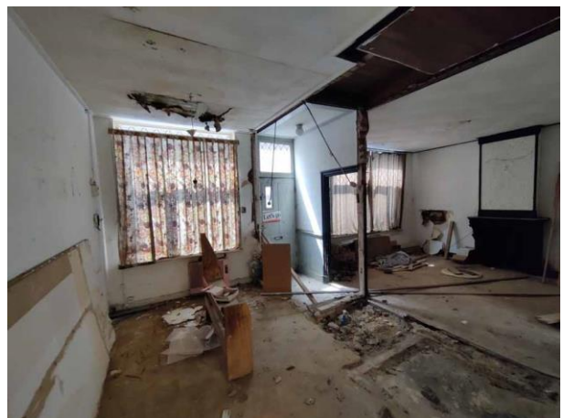
Figuur 7 Begane grond in het noordelijke deel van het pand
