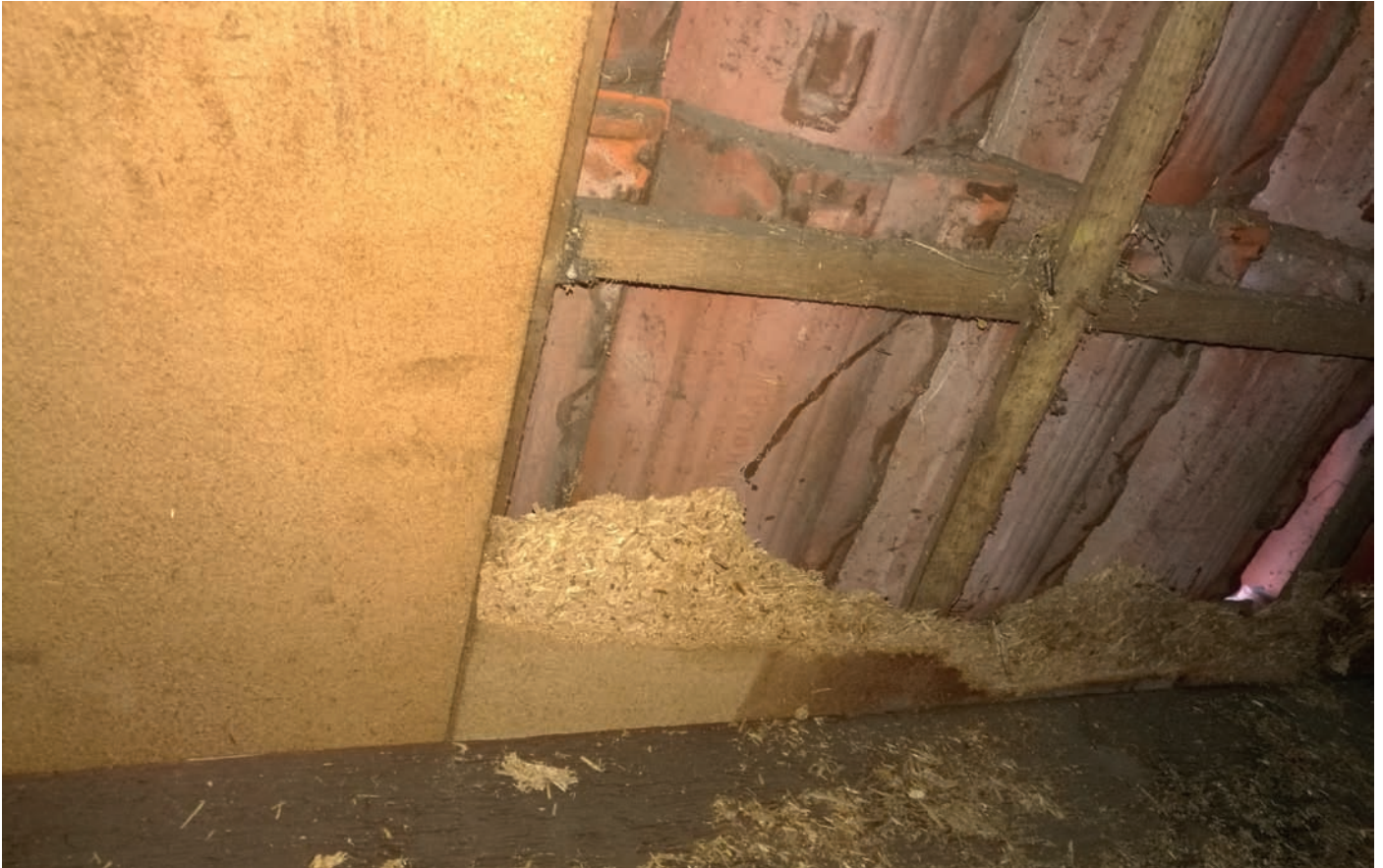
Foto 1: de spaanplaten van het dakbeschot ontbreken op sommige plekken
